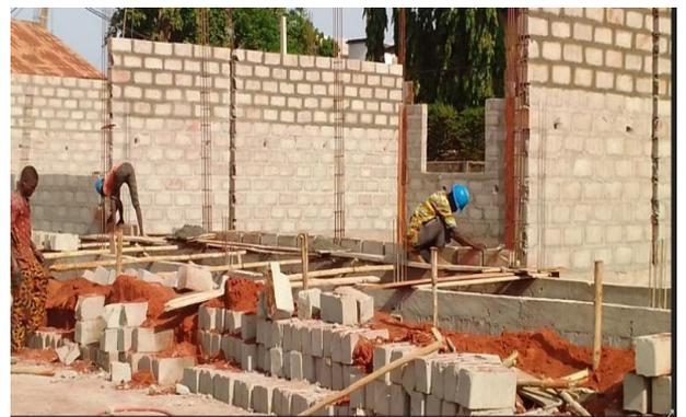
**PHOTO 2-6: Mur en élévation**
