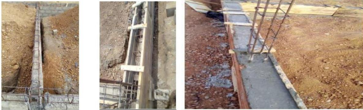
**PHOTO 2-5 : coffrage des chainages ; Coulage des chainages**
