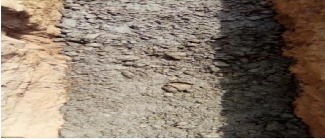
**PHOTO 2-2: Béton de propreté**
