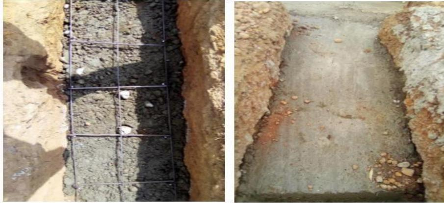
**PHOTO 2-3 : ferrailage de la semelle filante ; Béton de fondation**
