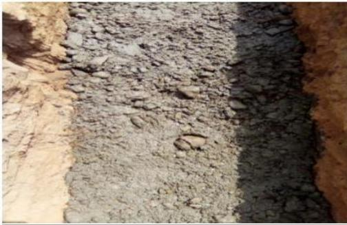
Photo : Béton de propreté
