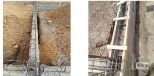
Photo : pose de ferrailage et coffrage
